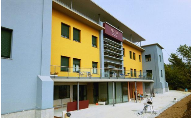
Imagen de archivo de una de las residencias afectadas / NACHO ARTERO
