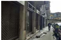
Cae un rótulo metálico en Gros sin causar daños personales DIARIOVASCO
